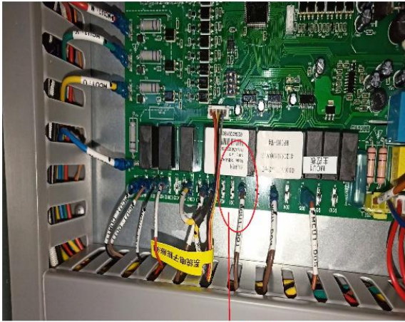
DO 8端口位置 电磁阀L线接线处
